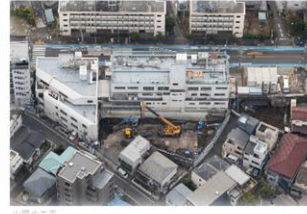
工事進捗状況(2025年3月末)
